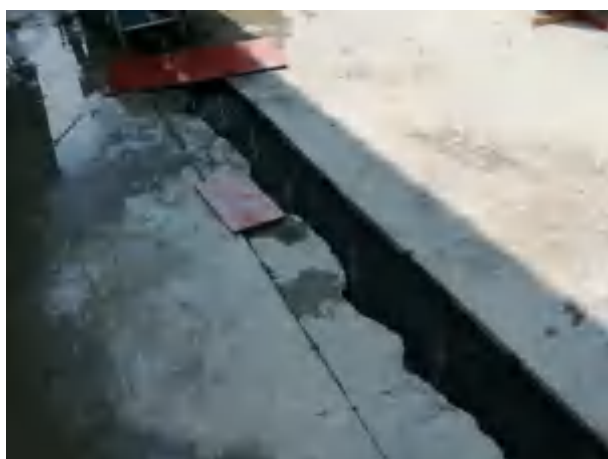
道路广场区临时排水沟（2021.08）
