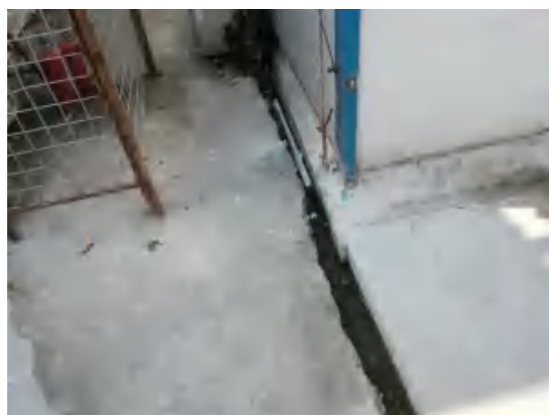
道路广场区临时排水沟（2021.08）
