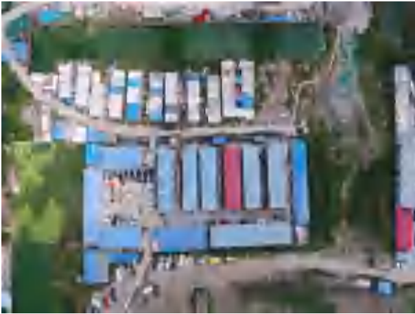
施工生产生活区（2021.09）
